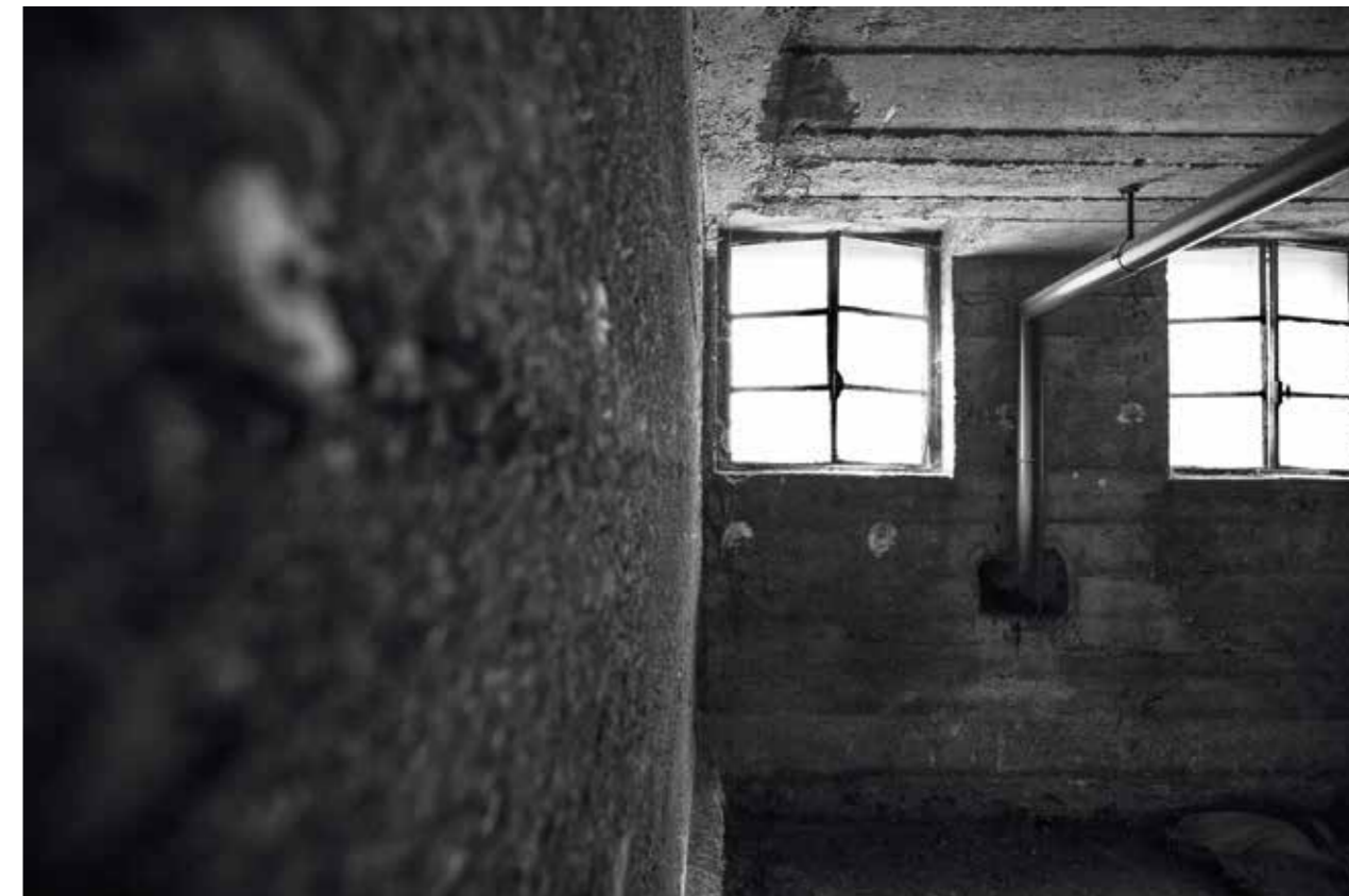
Dettaglio dei cementi originali del 1937
